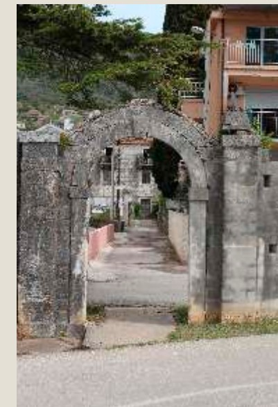
Ulazni portal, foto M. Nikolić
