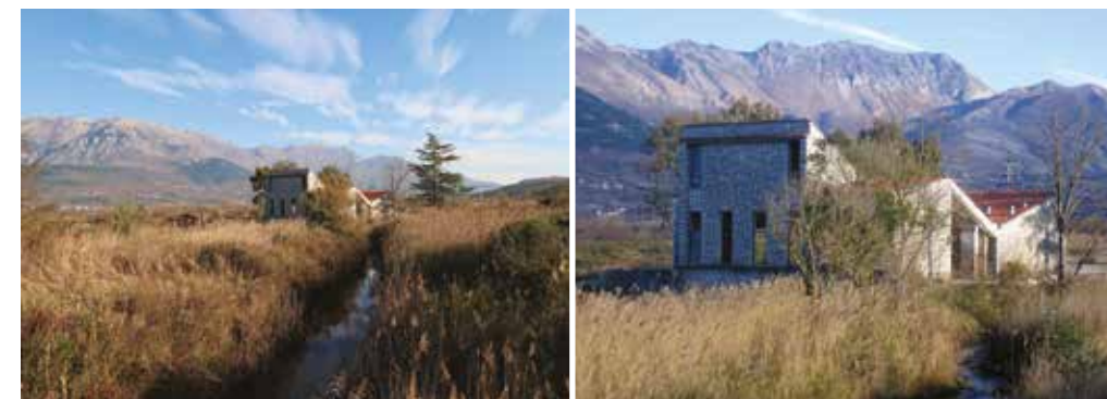
△ Pogonska zgrada i crpna stanica, sjeverna i istočna fasada
