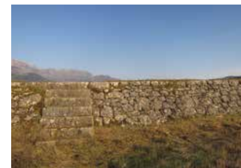
△ Detalj glavnog nasipa
