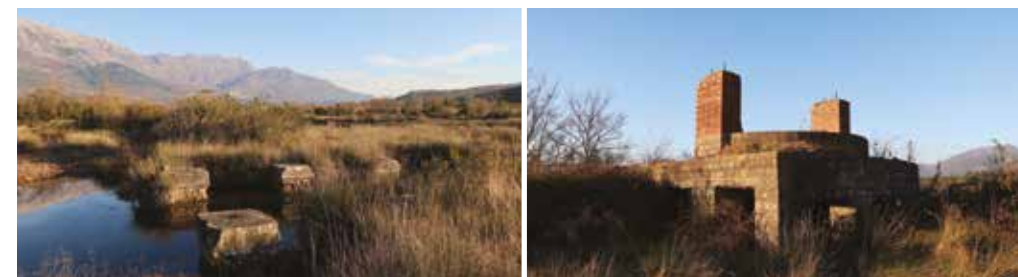
△ Betonske stope stubova žičare u blizini okretne stanice i okretna stanica
