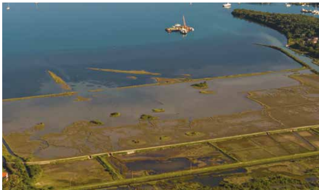
△ Ostaci I grupe bazena koncentracije pod morem, sa kristalizacionim bazenima i bazenima IV isparenja u prvom planu
